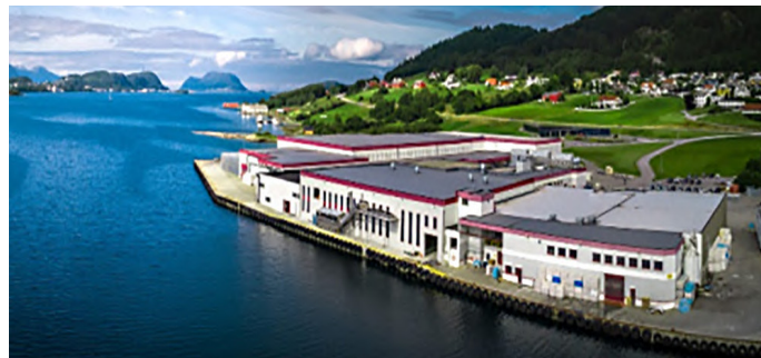
Brødrene Sperre A/S sitt anlegg på Ellingsøya
