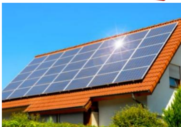
Bilde av en typisk solcelleinstallasjon på et tak
