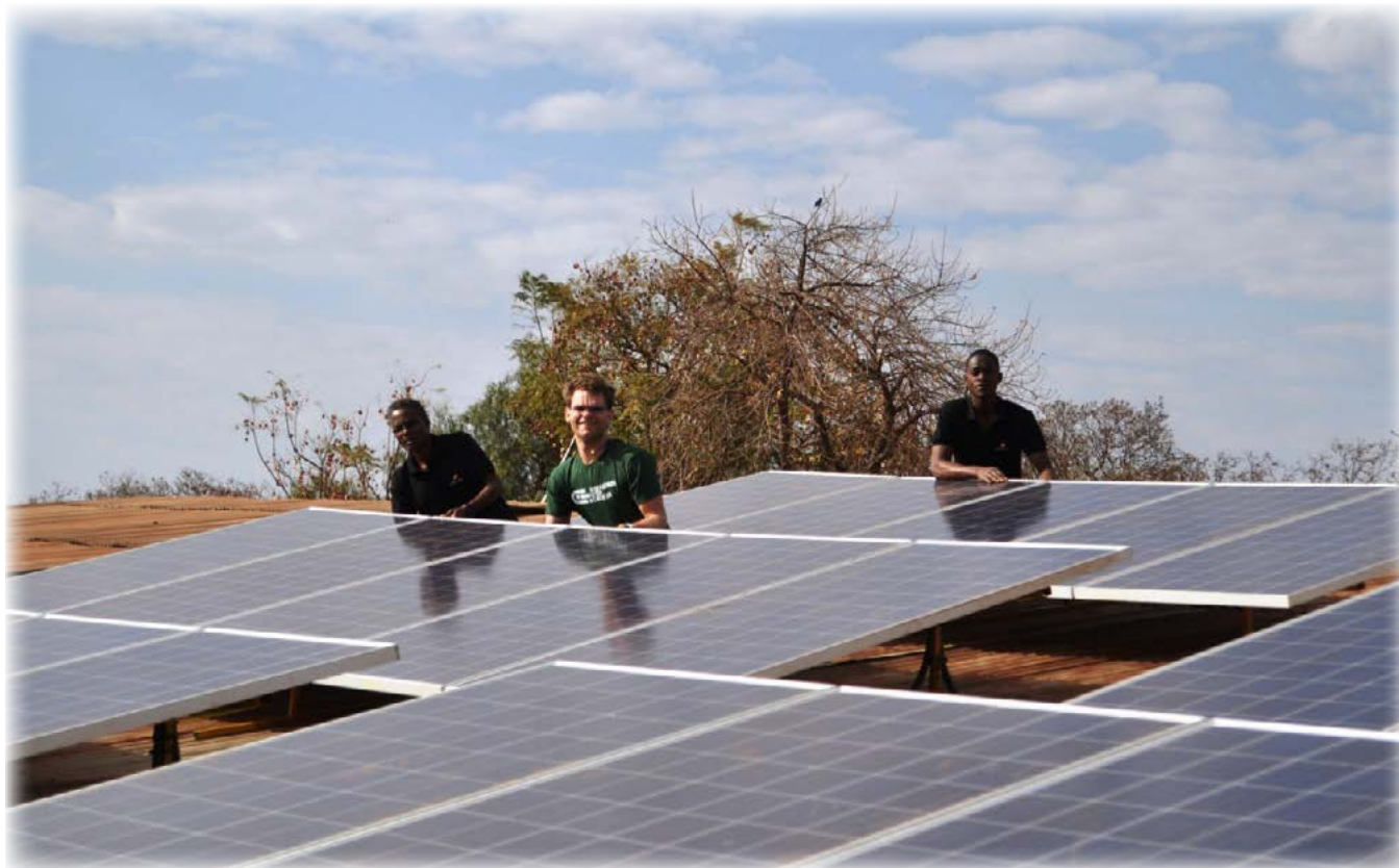
Montering av solenergianlegg på sykehus i Tanzania. Foto: K. Fløgstad
